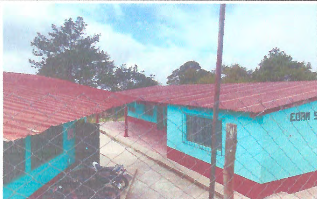
Foto 1: Mejoramiento cubierta de lámina ( cambio de lámina en toda la escuela).
